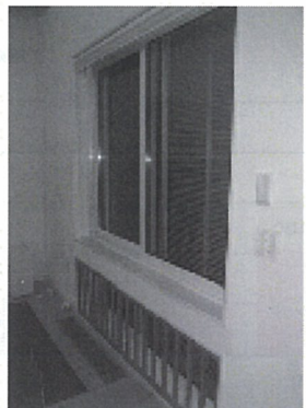
図2 防犯性を考慮した開口部遮断装置の例 開口部遮断の仕組みで、地震 (2階建) による揺れに耐えています
